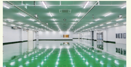
“Fabbrica 流延 SCR 施工法”施工场景
